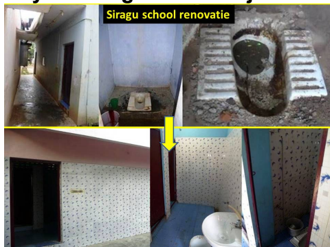
Renovatie van de toiletten
