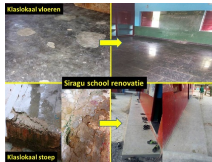
Renovatie klaslokaal vloeren en stoepen
