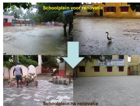
Renovatie van het schoolplein
