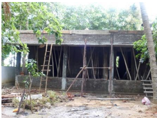
Klaslokalen in aanbouw ARMDS campus
