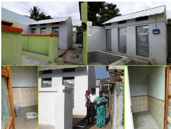
Nieuwe toiletten kinderkuis RCT Mugaiyur.
